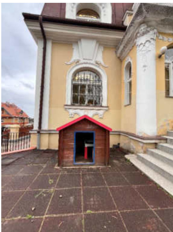
Východní průčelí objektu - hřiště
