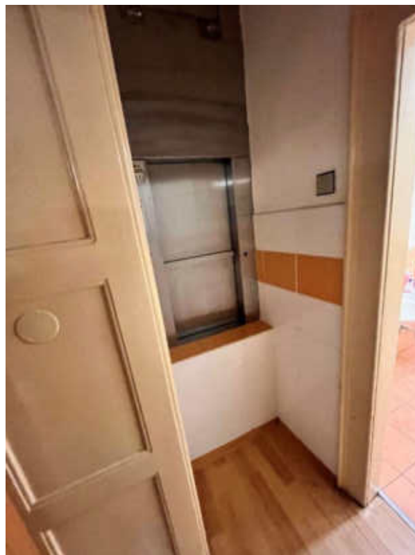
Výtah na jídlo
