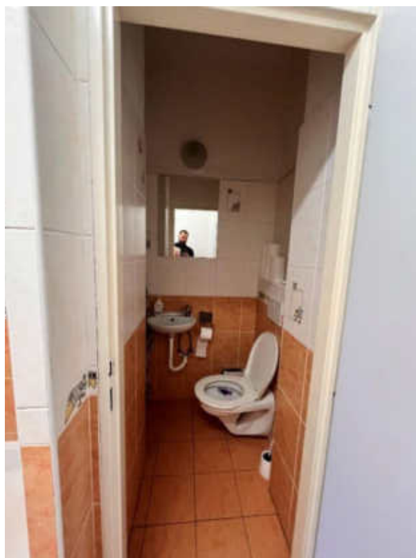
WC učitelé + úklidová místnost
